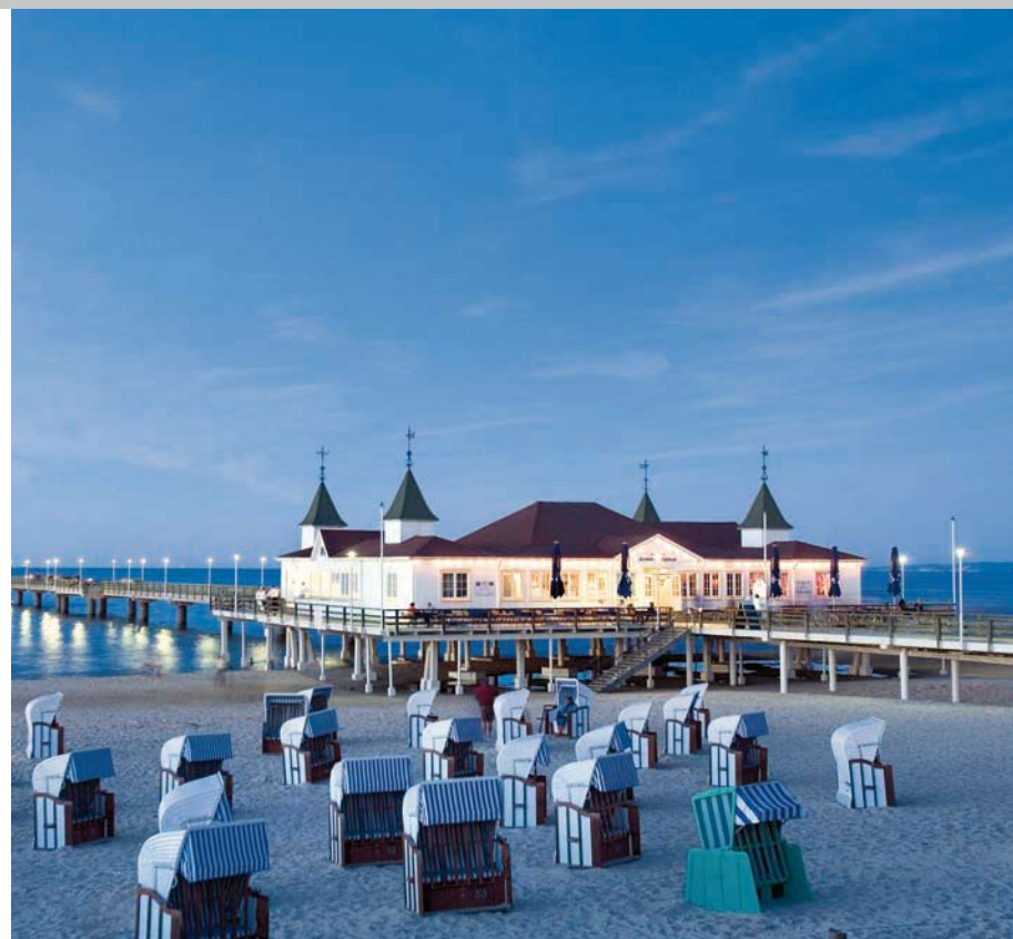
Ahlbecker Seebrücke // Ahlbeck pier
